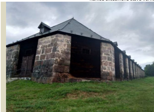
Varňa František v NKP Solivar v Prešove a detail poškodenia nosných častí objektu
